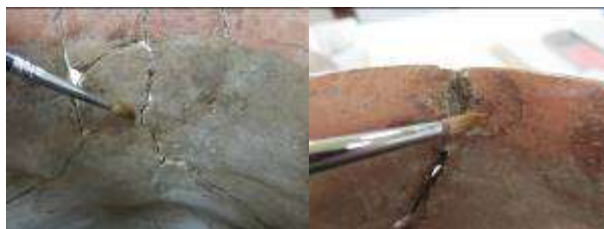
(Fig. 14).Remoción superficial (de la Calle, 2012)
