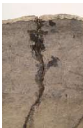
Adhesivo en uniones (Rivas, 2014)
