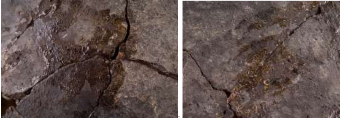
Excesos de adhesivos. (Rivas, 2013).
