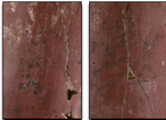
Manchas; pre-intervención (Rivas, 2014)
