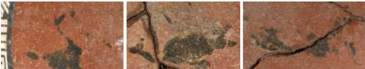
(Fig. 10). Desportillamiento, Pre-intervención (Rivas, 2012)
