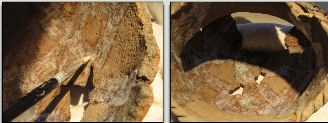
Refuerzos estructurales (de la Calle 2012)
