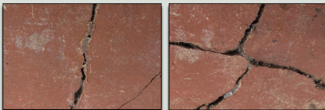
Exceso de adhesivo en uniones y superficie (Rivas 2011)
