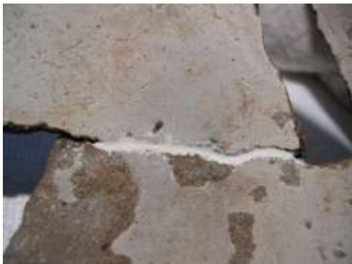
Resane para refuerzo estructural
