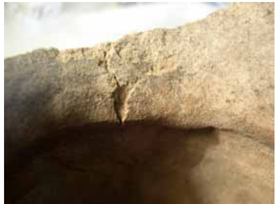
Vista interior de grieta en cuello asociada a deplacamiento.
