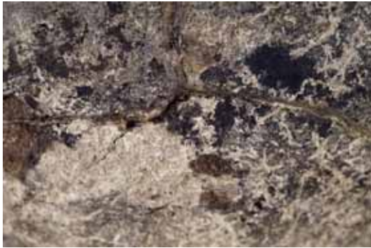
Concreciones en superficie y exceso de adhesivo
