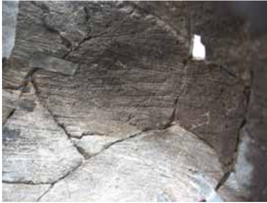
Detalles acabado superficial interior
