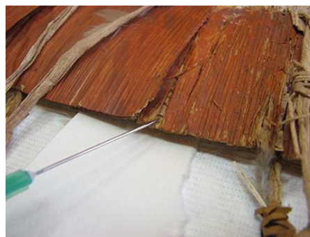
Imagen nº 40: Inyección de mezcla consolidante en área de borde de la falda.
