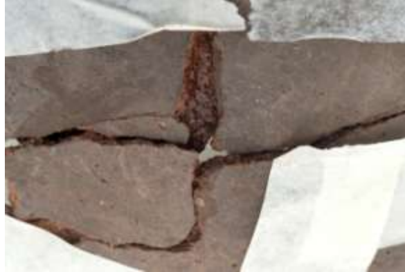
Detalle exceso de adhesivo en unión de fragmentos. (Rivas, 2013)
