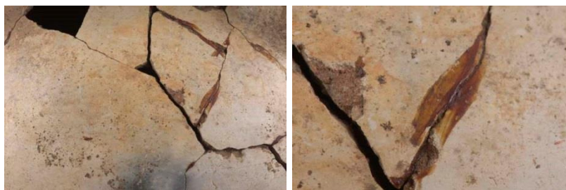
(Fig. 20) Adhesivo en uniones y superficie, Pre-intervención (Ormeño 2016)
