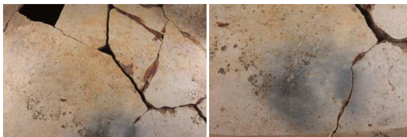
(Fig. 19). Mancha, Pre-intervención (Ormeño 2016)
