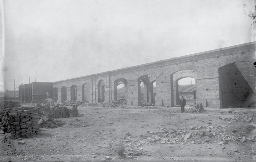
Fig. 23. Palacio de Bellas Artes en construcción | 1908 | Fotografía Archivo Patrimonial Ministerio de Obras Públicas
