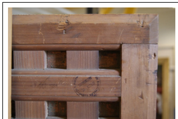
Detalle de los distintos elementos del engatillado. (M. Pérez, 2013)
