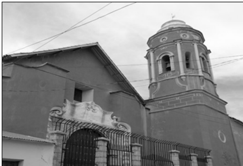
Típica torre del Monasterio de los Remedios
