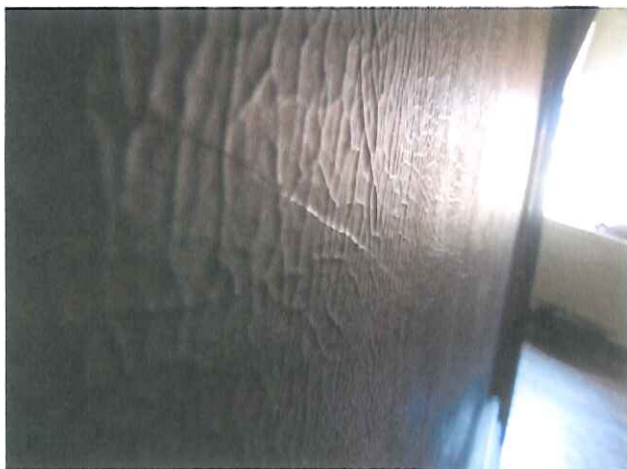
Vista con luz rasante de alteraciones de marcas y fisura respectivamente
