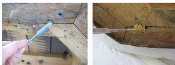
Figura 31. Relleno con pasta de serrín de madera de nogal y cola de conejo al 7% en agua destilada (con 2-3 gotas de antifementativo Eugenol®) de los orificios de los tornillos originales de la base de la peana (Fotografías: Archivo CNCR, Miori, G., 2016).
