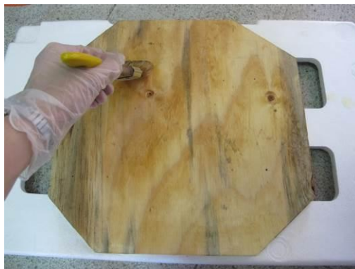
Aplicación de impregnante en la superficie de la cubierta. (Miori, G. 2016. Archivo CNCR)
