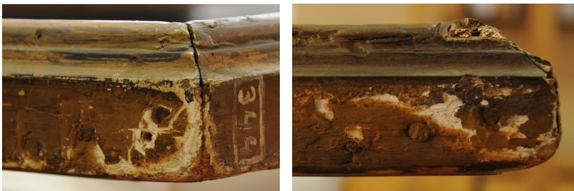
Detalles de ensamble mediante tres clavos
