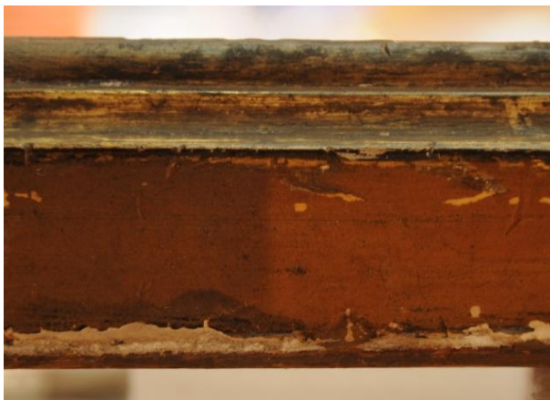
Limpieza mecánica mediante goma de borrar
