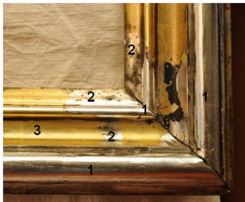
1. Plata falsa nueva, 2. Plata fina original y 3. Plata corlada original
