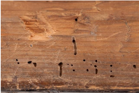
Detalle de los orificios de salida de insectos en el listón afectado.. (Archivo CNCR, Rivas, V., 2013)
