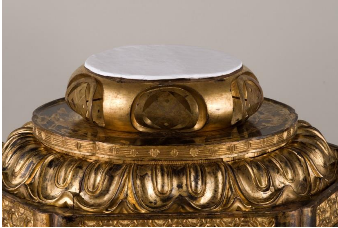
Este elemento de montaje permite un mejor calce entre la Base circular y la Base flor de loto. (Archivo CNCR, Rivas, V. 2014)
