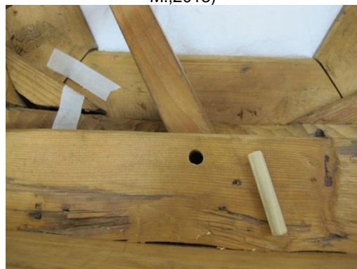
Preparación del entarugado de los travesaños/listones para su fijación. (Archivo CNCR, Chamoux, C.,2013)
