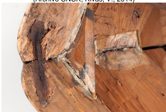
Sub-base inferior: se nota el grapado, la adhesión de cuñas triangulares para reforzar la unión de bloques y la presencia de refuerzo de papel en las juntas de bloques. (Archivo CNCR, Rivas, V., 2013)
